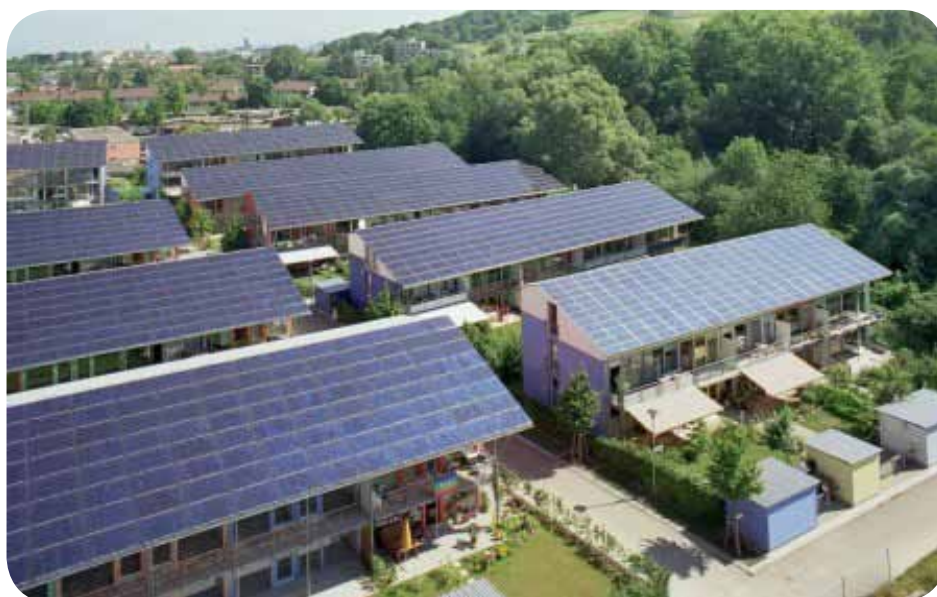
Un sistema di impianti fotovoltaici a Vauban
